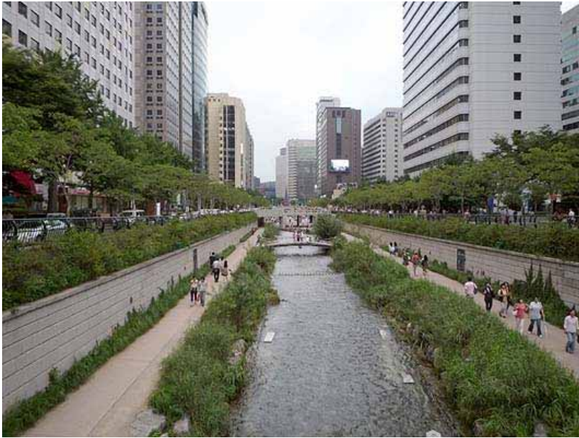
Abb. 4: Durch den Rückbau einer mehrspurigen, mehrstöckigen Straße aus den 60er Jahren wurde der Cheonggye-Fluss zu einem beliebten Erholungsbereich umgestaltet. Zentrales Element ist ein neuer, künstlicher Fluss quer durch das Zentrum der Stadt Seoul. Die Spazierwege an den Ufern werden von vielen Bürgern genutzt. © Hea-Jee Im
