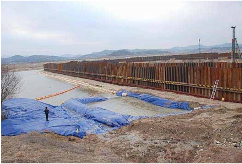
Abb. 2: Baustelle der Buyeo-Staustufe am Geum-Fluss. Die Buyeo-Staustufe ist 7 m hoch und 620 m lang (500 m fester Teil und 120m beweglicher Teil). Die aufzustauende Wassermenge beträgt 23.5 Millionen Kubikmeter. Die künftige durchschnittliche Flusstiefe wird 4.6 m, die durchschnittliche Flussbreite 294 m betragen. Foto: © Byoung-Sung Choi
