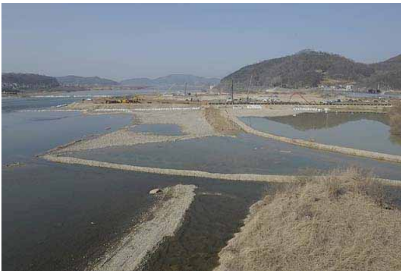
Abb. 3: Baustelle der Ipo-Staustufe am Han-Fluss. Die Ipo-Staustufe ist 6 m hoch und 591 m lang (296 m fester Teil und 295m beweglicher Teil). Die aufzustauende Wassermenge wird bei 17 Millionen Kubikmeter liegen. Foto: © Byoung-Sung Choi
